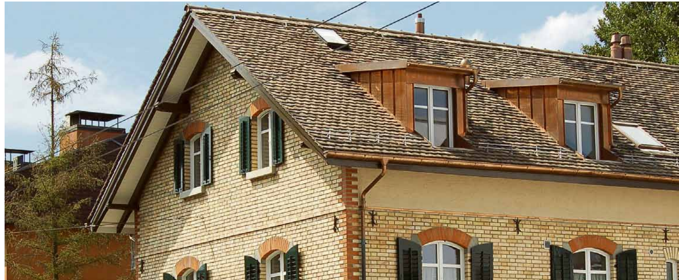
In diesem Backsteinhaus in Zürich wurde kürzlich der gesamte Dachstock saniert und mit neuen Dachluken und Fenstern versehen. Auch diese Arbeiten unterliegen einer Garantiefrist.
