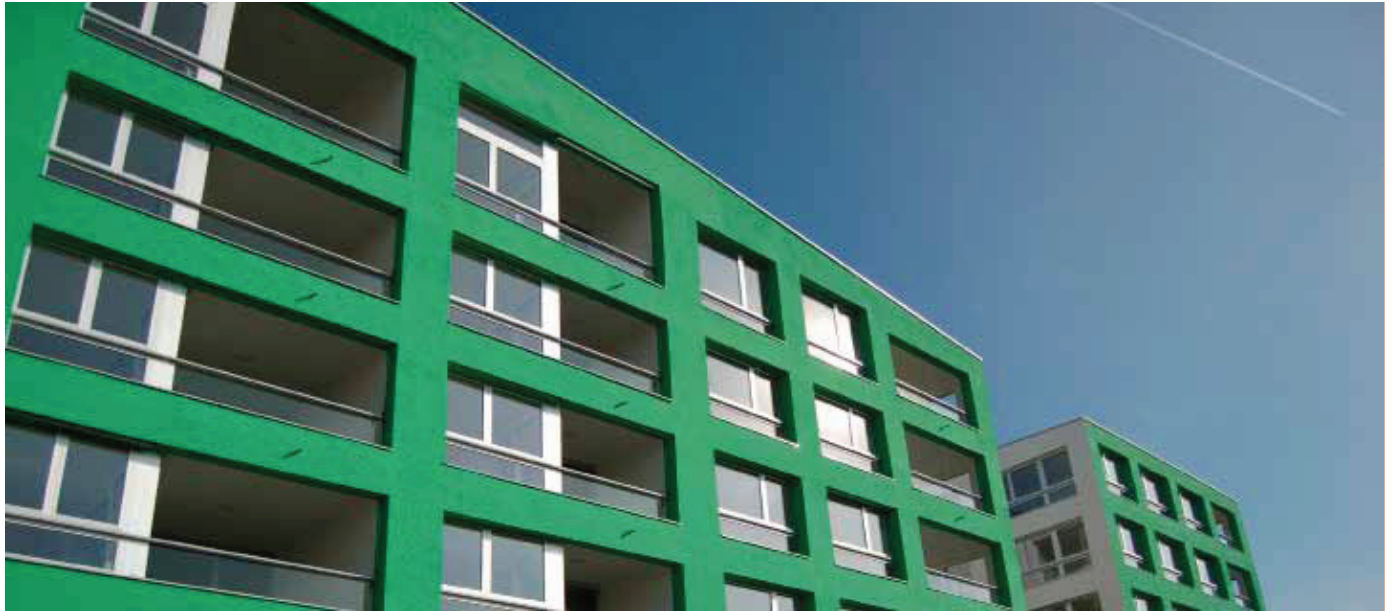
Gerade bei Neubauten, wie hier bei der Mehrfamilien-Überbauung «Limmatfeld» in Dietikon kommen neue Farben zum Einsatz und machen das Gebäude somit von weitem sichtbar.
