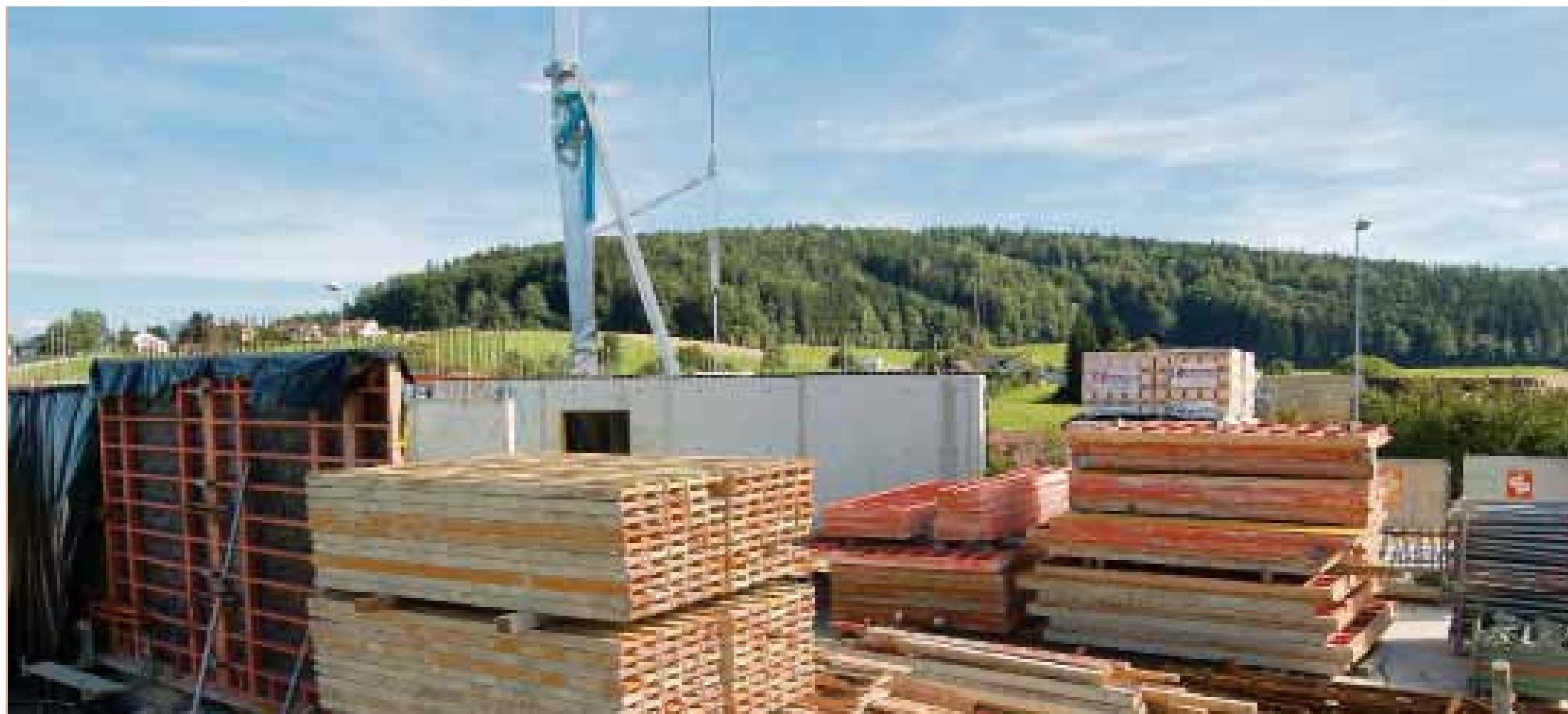
Beim Bau eines Mehrfamilienhauses – wie hier vor den Toren Zürichs – müssen gemäss Bauplan viele Arbeiten parallel verrichtet werden.
