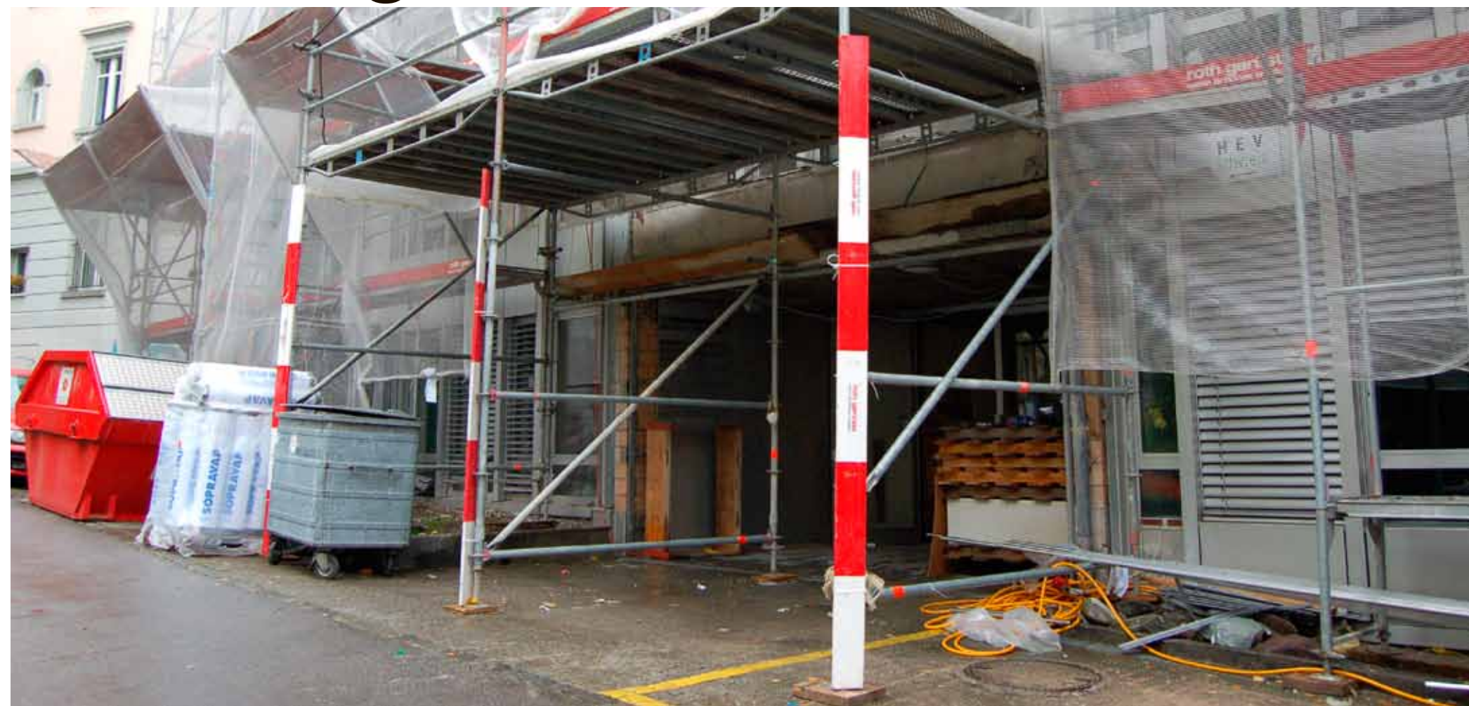
Wie gross, mit welchen Materialien darf gebaut werden? Welche Grenzabstände gelten? Wie ist die maximale Ausnutzungs- oder Baumassenziffer bestimmt? Diese Fragen sind nicht nur für grosse, sondern auch für kleinere Bauarbeiten relevant.
