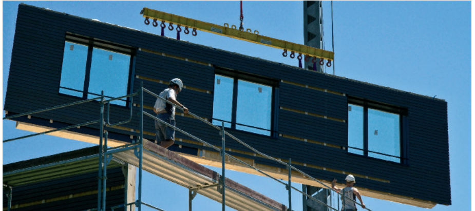
Bauen in Rekordzeit: Vorgefertigte Wandelemente machen es möglich.
